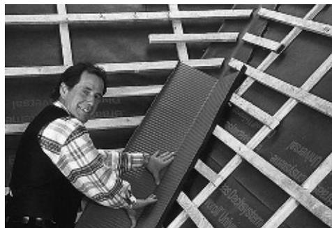
Рис. 7. Сомнительная конструкция: крепление обрешётки к настилу ендовы снижает надёжность конструкции от протечек талой воды
