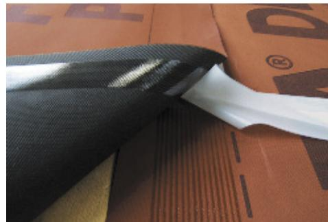
Рис. 5. Водонепроницаемое соединение нахлёстов диффузионной мембраны, имеющей встроенные самоклеящиеся ленты
