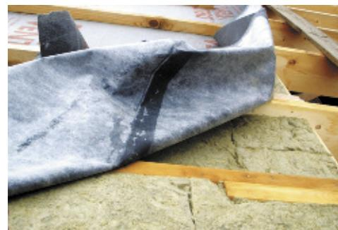
Рис. 2. Протечка дождевой воды под контробрезетку
