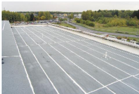
Нанесение кровельного рулонного материала на «УЛЬТРАСИЛ». Швы обработаны этой же мастикой
