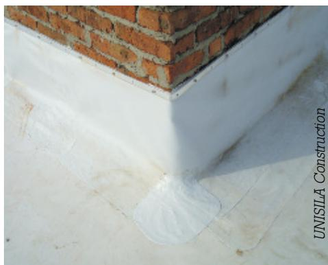
Под гидроизоляционные материалы из ПВХ необходимо укладывать разделительные слои, если того требует подоснова и если рулонный материал не имеет с обратной стороны специального предохранительного волокна. Для устройства разделительного слоя применяют геотекстиль или стеклохолст.
