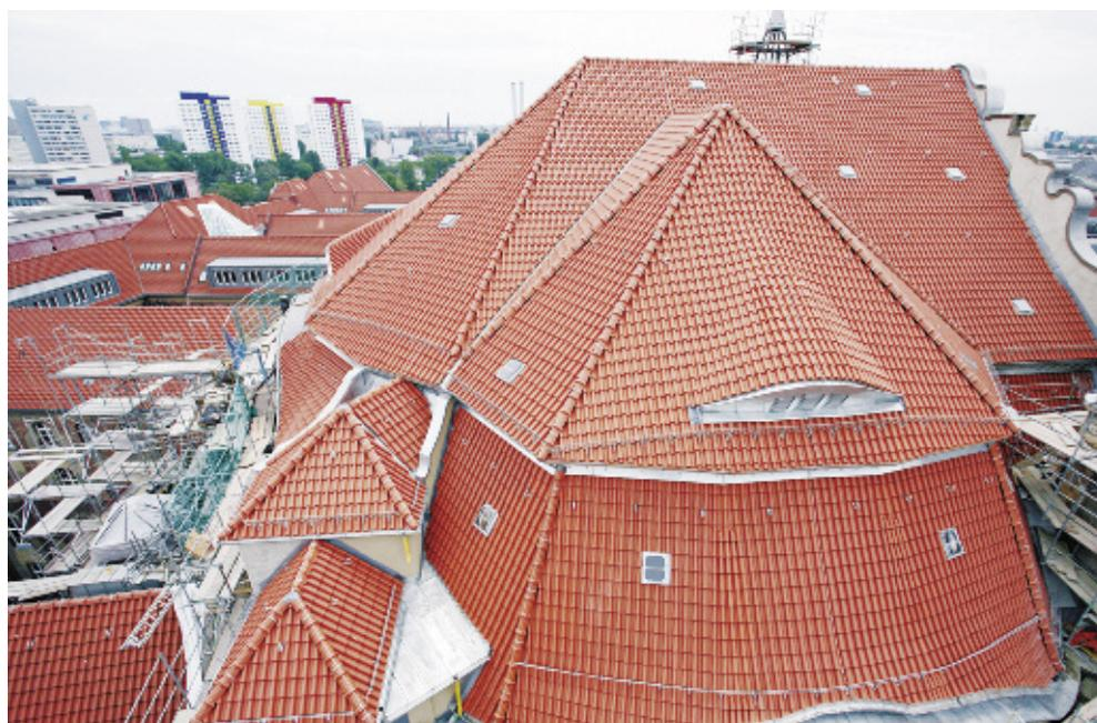
Куполообразная кровля над вестибюлем состоит из большого количества разнообразных участков. Слуховые окна и сводчатые поверхности требовали очень гибкой системы покрытия, которая следовала бы сложной геометрии кровли
