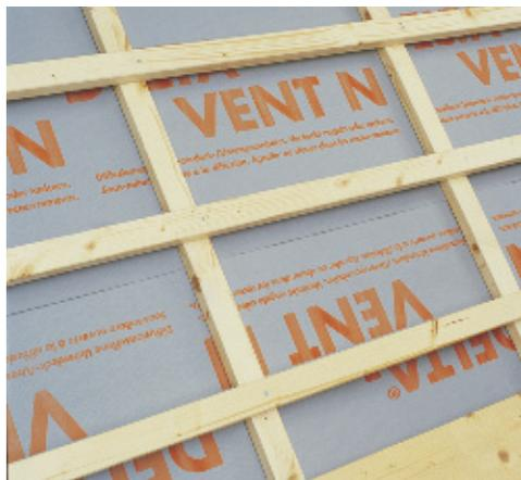
Рис. 1. Набиваемая на стропила контробрезетка может стать элементом, под который через гвоздевые отверстия затекает талая или дождевая вода. Это особенно опасно, когда уклон ската менее 20° и кровля имеет сложную форму
