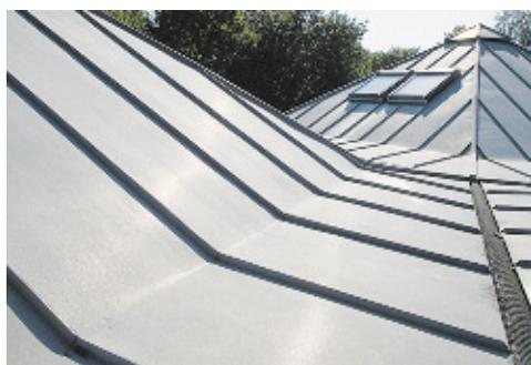
с битумсодержащих элементов или при контакте с кровельным картоном начинают активно корродировать. Весь накопленный опыт применения нержавеющей стали указывает на абсолютную неуязвимость материала к подобного рода воздействиям. Более того, если решено «залечить» кровлю листами из нержавеющей стали, то с ее поверхности можно даже не удалять битумных лент и изоляционных материалов. Также при применении
