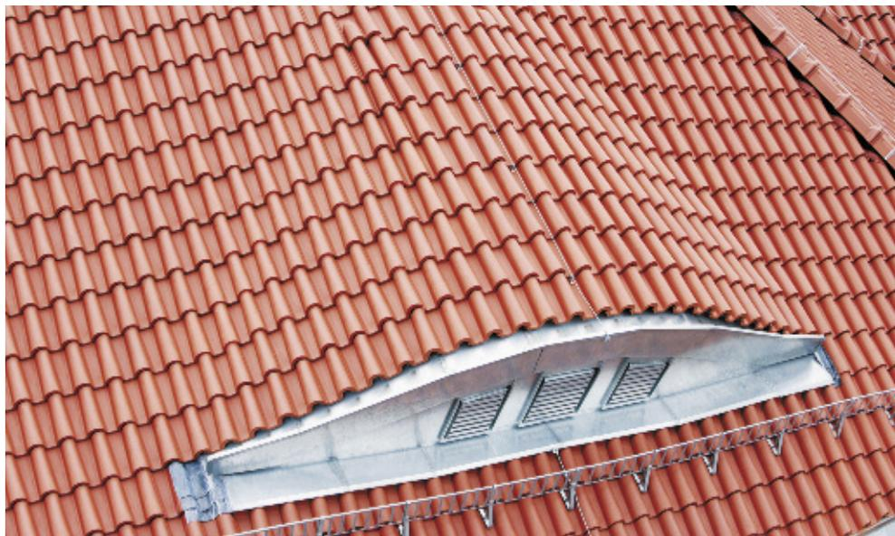
Устройство слуховых окон. На сегодняшний день гибкие элементы обрешетки из полимерных материалов позволяют организовать плавный переход от поверхности кровли к закруглению слуховых окон
