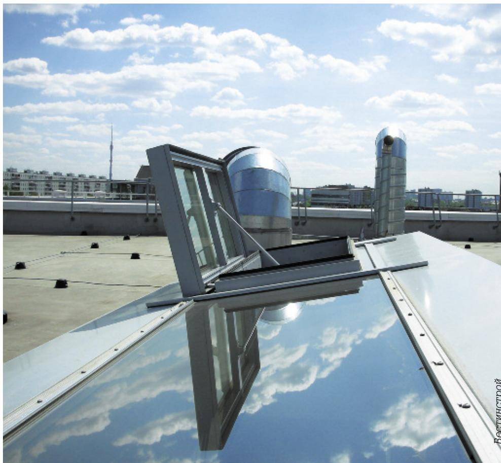
Начнём с определений. Дымовой люк (дымовой клапан, фонарь или фрамуга) – конструкция заполнения проема покрытия или ограждения здания и сооружения (как самостоятельная конструкция или как конструктивно выделенный элемент в составе конструкций остекления, световых или светоаэрационных фонарей), предназначенная для выброса продуктов горения при пожаре непосредственно из помещения, защищаемого системой вытяжной противодымной вентиляции с естественным побуждением тяги наружу.
