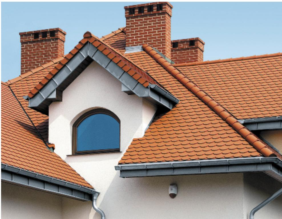
Из всего многообразия кровельных комплектующих наиболее заметными являются водостоки. Водосточная система выполняет целый ряд функций, из которых декоративная – вовсе не самая главная. Отвод воды с кровли в дренаж предотвращает размывание фундамента, защищает стены от неэстетичных следов грязи и сырости, а тротуары и дорожки – от разрушения и образования опасной наледи. Кроме того, современная, хорошо продуманная водосточная система придает кровле завершенный вид и расставляет стильные акценты.
