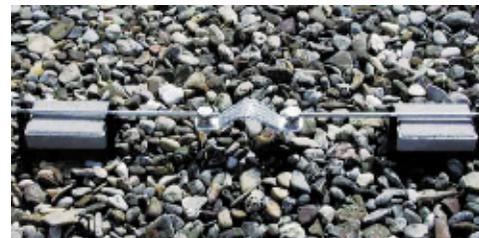
Рис. 6. Соединения, компенсирующие напряжения, возникающие при изменении температуры
