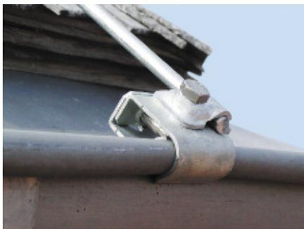
Рис. 8. Пример выполнения соединений металлического водосточного желоба с элементами молниезащитного устройства
