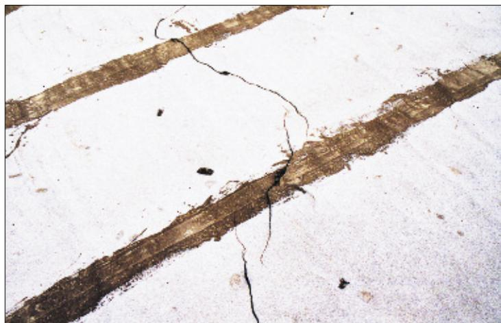
Рис. 1. Поверхность кровельного ковра из рубероида после нескольких месяцев эксплуатации
