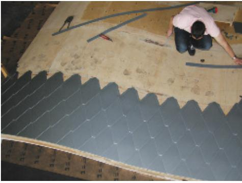
Для облицовки поверхностей малого радиуса следует применять ОДМ. Это сгладит неровную поверхность обрешетки и снизит шумовой эффект. Кляммеры обычно крепятся к подконструкции с помощью кровельных гвоздей или саморезов. Выбор способа крепления зависит, прежде всего, от вида и особенностей подконструкции, также необходимо учитывать ветровую нагрузку, ширину и толщину металлического листа.
