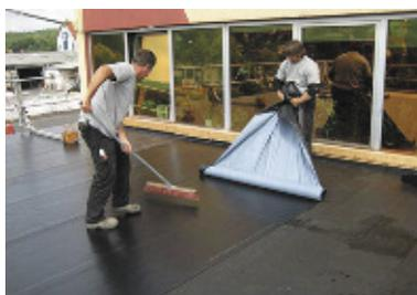
Необходимо отметить гидроизоляционную мембрану TESTOFIN RV на основе акрилового синтетического каучука. Произведенный методом экструзии материал дополнительно каширован высокопрочным холстом из полиэфирного волокна. Край мембраны, по которому выполняется сварка, остается свободным от кашировки, что обеспечивает удобство и скорость выполнения монтажных работ.
