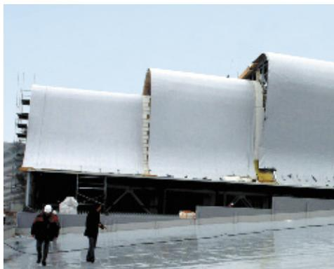
Недавно в активе мастеров-кровельщиков появился новый полимерный материал и технология, позволяющая имитировать с его помощью металлические кровли с фальцевыми соединениями. Инновационное решение, предлагаемое компанией Sika, позволяет кровельным полимерным мембранам успешно конкурировать не только с различными рулонными материалами, но и с металлами.
