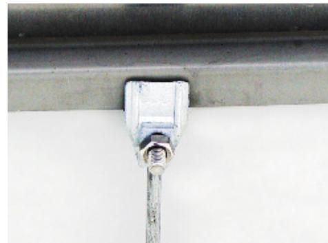
Рис. 10. Отведение тока молнии с металлического покрытия крыши
