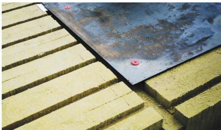
Участок ремонтируемой крыши с верхним слоем из минераловатных плит, диффузионными и вентилируемыми каналами и сборной стяжкой из ЦСП
