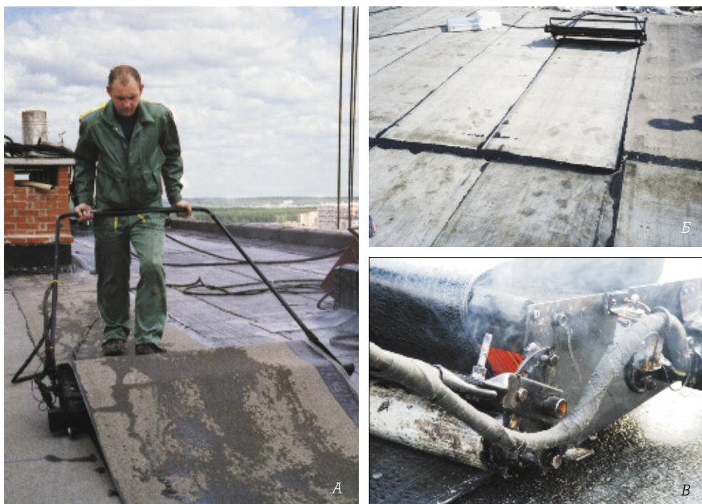
Рис. 4. А – общий вид электрической инфракрасной кровельной машины в работе; Б – вид сбоку: нагрев материала производится без открытого пламени и с прикаткой материалов; Б' – общий вид наклеенного рулона наплавляемого материала. По торцам материала виден выход расплавленной битумной мастики, являющейся показателем качества приклеивания материал; Г – общий принцип устройства и работы электрической кровельной машины инфракрасного излучения:
