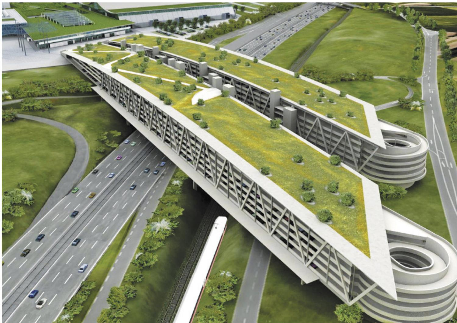
*Суперсовременная крытая автостоянка выставочного центра в Штутгарте представляет собой единый пролет над автобаном. Только в концевых частях 24 опоры воспринимают силовые нагрузки. Доступ на автостоянку возможен прямо с автобана*
