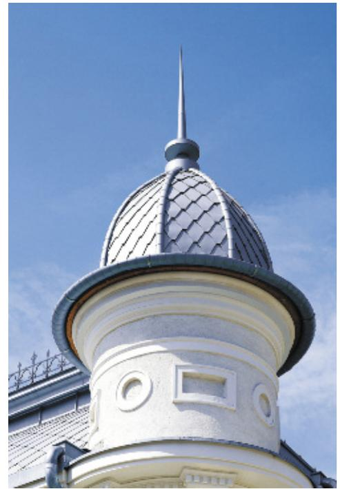
толщиной 0,8 мм. Была применена техника укладки «Большие ромбы»: от основания купола (размер кровельных элементов 1250x600 мм) до отметки 15 м вверх по образующей, где ромбы уменьшились до 600x600 мм. В течение полугода титан-цинк RHEINZINK подвергался процессу естественного патинирования. Сегодня все авторы и исполнители работ отмечают глубокий и благородный оттенок выбранного естественного материала, не требующего ни окраски, ни особого ухода.
