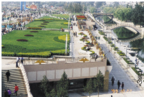
Эксплуатируемые кровли на крышах общественных объектов позволяют использовать для практических целей значительные площади городских территорий
