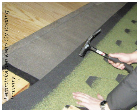
В процессе обучения подкладочный ковер всегда присутствует
