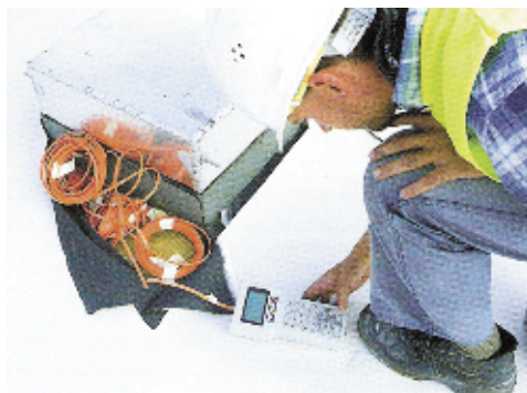
Сенсорный контроль кровли комплекса BMW
