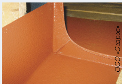
Узел примыкания к трубе из алюминия Prega, выполненный вручную
