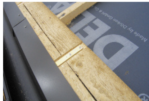
Рис. 8. Конструкция с высоким расположением желоба
