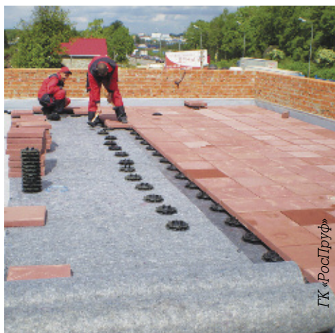
Монтаж тротуарной плитки на эксплуатируемой кровле
