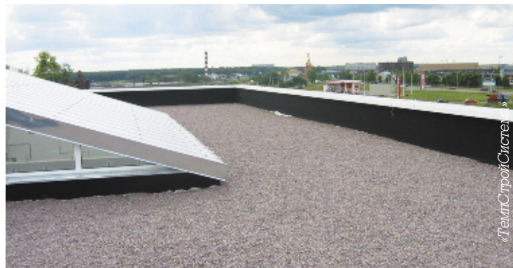
В настоящее время в нашей стране технология устройства балластных кровель с гравийной засыпкой имеет ограниченное применение
