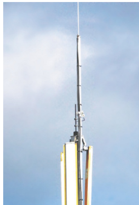
Рис. 8. Пример использования кабеля в изоляции высокого напряжения, покрытой полупроводящим материалом, для отвода тока молнии [2]
