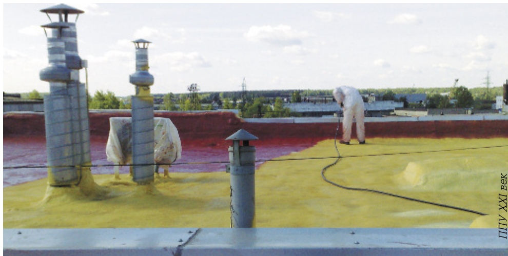
Нанесение напыляемого ППУ
