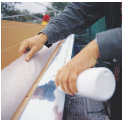
Рис. 2. Соединение мембраны и карнизной планки (фото DORKEN)
