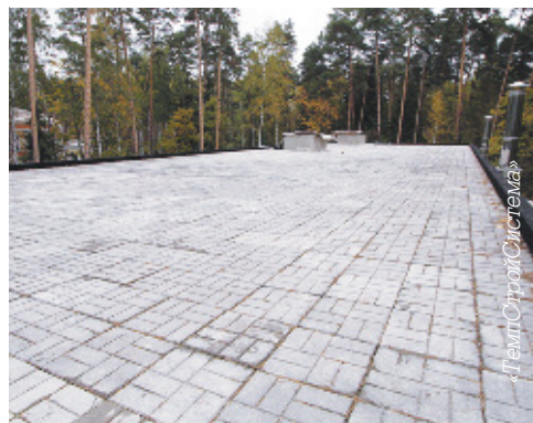
Пример организации эксплуатируемой кровли с покрытием из тротуарной плитки
