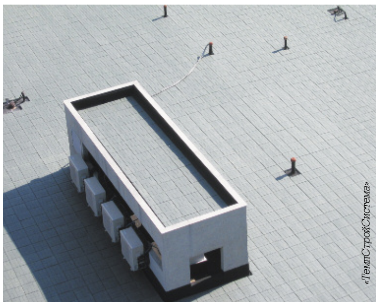
Покрытие из тротуарной плитки на кровле делает оборудование, установленное на крыше, доступным для эксплуатационных служб
