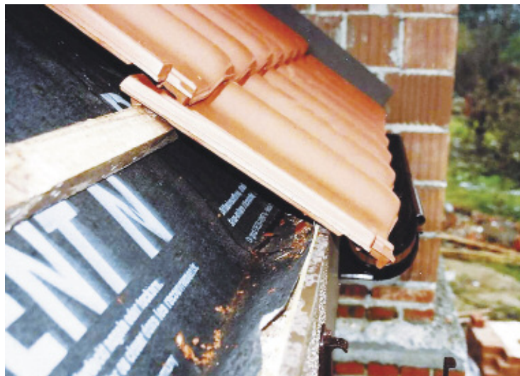
Рис. 3. Ошибка: желобок на карнизе (фото DORKEN)
