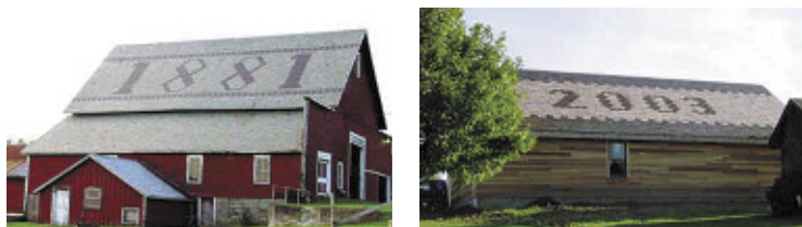
Узор с изображением даты постройки здания
