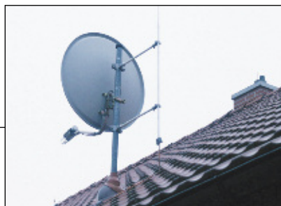
Рис. 4. Защита мачты и антенны от прямого удара молнии [2]
