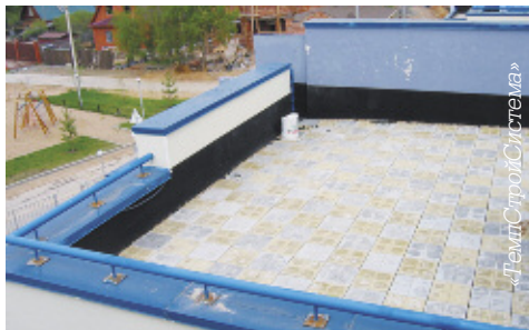
Эксплуатируемая кровля многоэтажного здания
