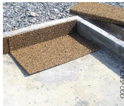
Установка основы вибро- и звукоизоляции (агломерированная пробка в пластинах) для системы кондиционирования на крыше жилого дома
