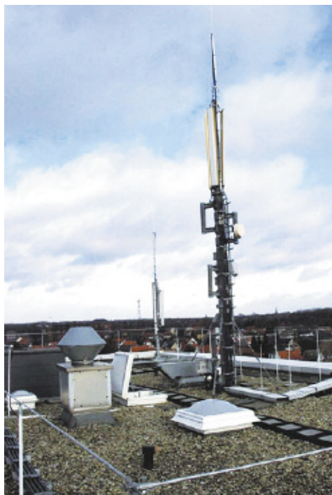
Рис. 8. Пример использования кабеля в изоляции высокого напряжения, покрытой полупроводящим материалом, для отвода тока молнии [2]
