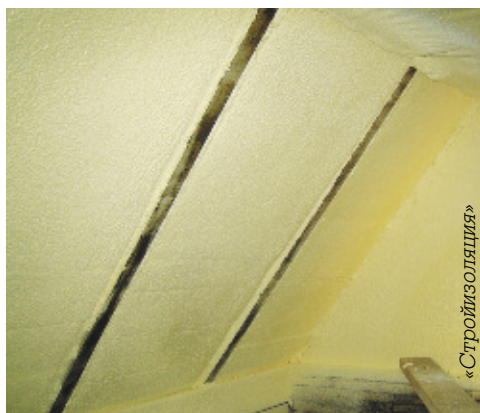
Утепление скатной кровли напыляемым ППУ
