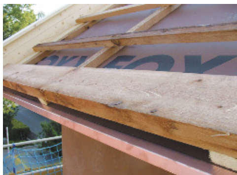
Рис. 5. Правильное исполнение: пленка защищена от воздействия УФ-лучей
