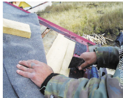
Замена подкладочного ковра на рубероид ни к чему хорошему не приводит...
