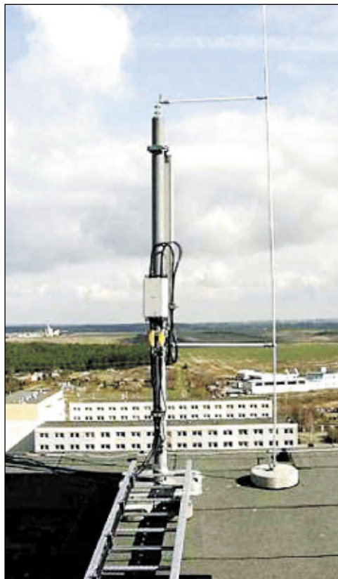
Рис. 5. Размещение антенных мачт в защищаемых вертикальными молниеприемниками пространствах
