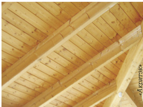
Укладка плит из ППУ поверх стропил позволяет создавать выразительные интерьеры
