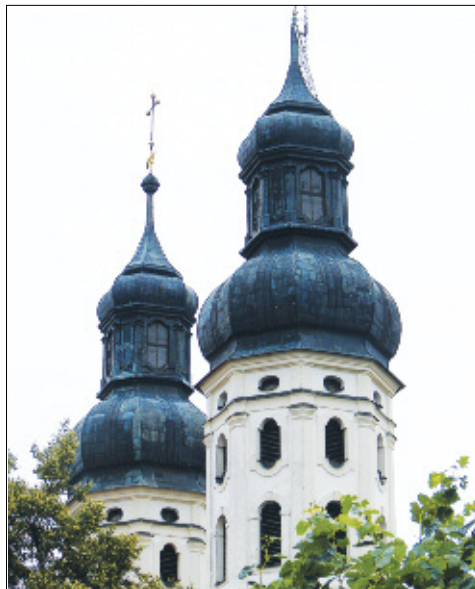
Пригород Ульма, кровля собора выполнена вручную «клемпнерами» – средневековыми кровельщиками-жестянщиками
