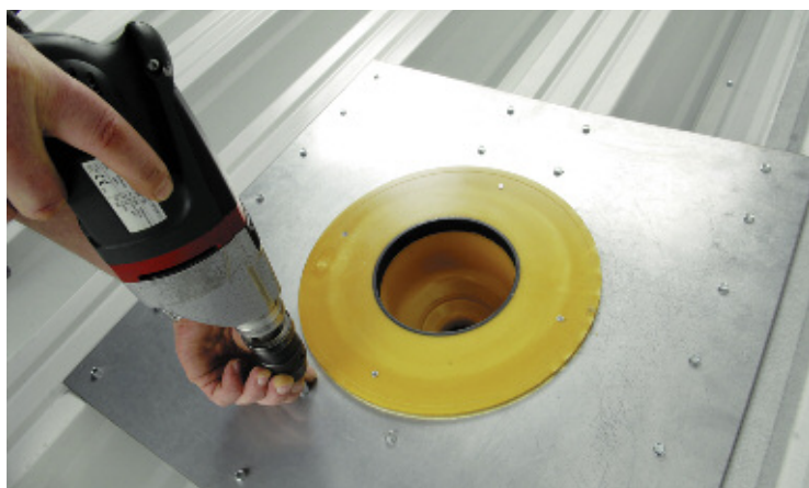
Исполнение и стабильность в области отверстия в профлисте, согласно DIN, обеспечивает усиленная пластина
