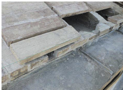
Монтаж основания под стяжку
