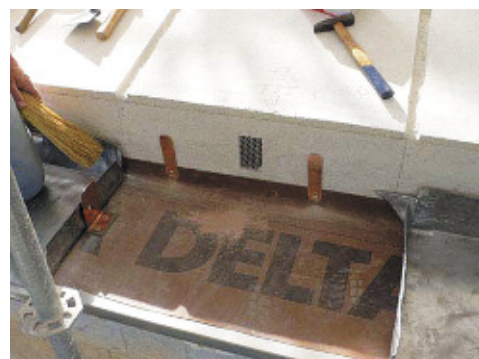
Благодаря кляммерам, будут «гаситься» ежедневные и сезонные температурные расширения металла, поэтому свинцовая кровля прослужит дольше
