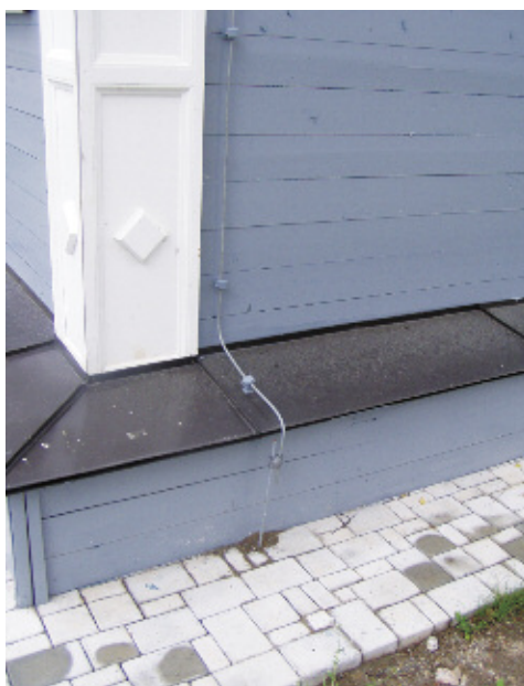
Примеры расположения токоотводов на различных зданиях
