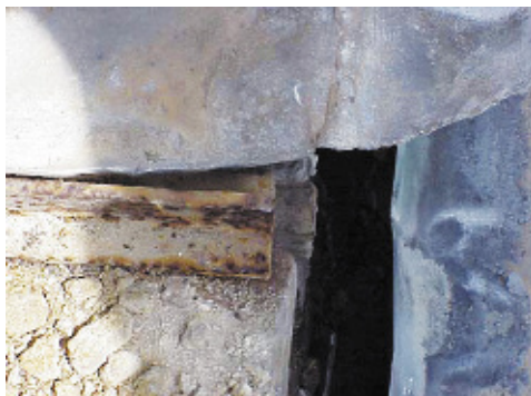
Фрагменты старого свинцового покрытия кровли
