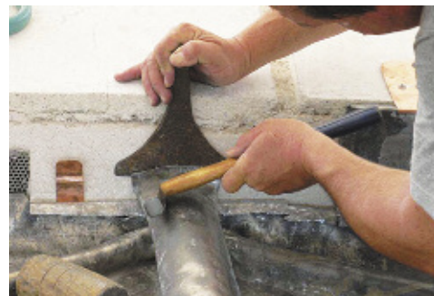
Благодаря кляммерам, будут «гаситься» ежедневные и сезонные температурные расширения металла, поэтому свинцовая кровля прослужит дольше
