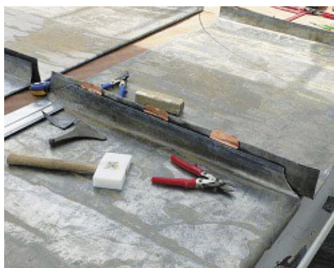
Фазы закрепления покрытия в свинце
