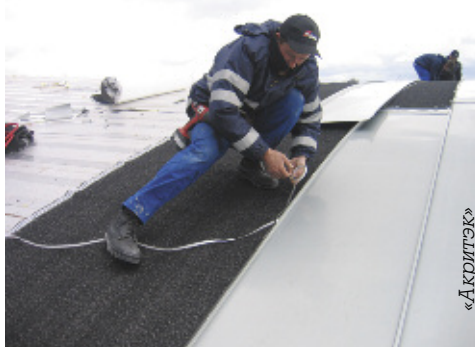
Качественная структурная мембрана выдерживает вес человека и упрощает передвижение рабочих по кровле в процессе монтажа
