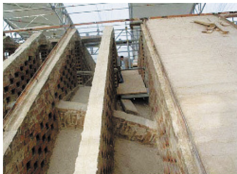
По проекту Партини, деревянные фермы центрального нефа были заменены на кирпичные конструкции. В ходе реставрации их расчистили, чтобы восстановить со временем нарушенную вентиляцию подкровельного пространства, местами заново выполнили кладку
