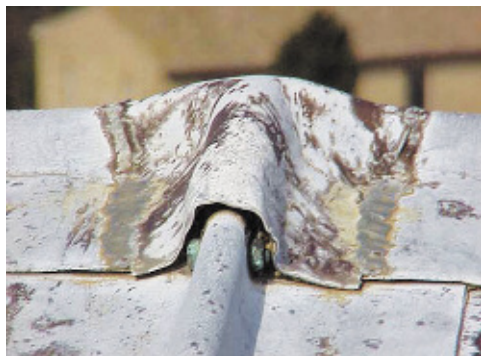
Кровельные листы были закреплены с помощью болтов между собой, а также на металлических профилях, скрепленных болтами, которые опирались на кирпичную балку
