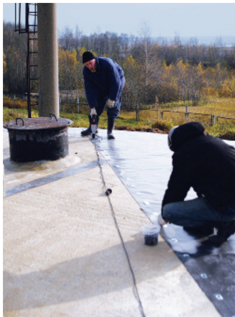
Рис. 3. Установка специального кровельного механического крепежа
