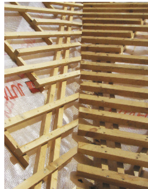
Рис. 3. Организация продольной вентиляции на крыше с микроперфорированной пленкой. Желобок ендовы монтируется на учащенную обрешетку. Достаточный провис пленки обеспечивает сток конденсата (фото автора)
