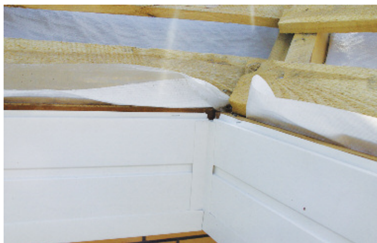
Рис. 9. Ошибка: водоотвод с ендовы перекрыт обрешеткой и подшивкой карниза
