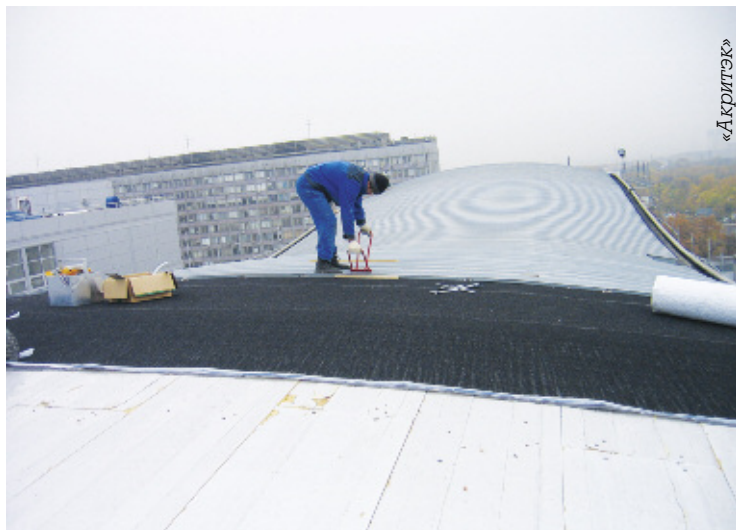
Монтаж кровли Третьего гуманитарного комплекса МГУ: малоуклонная кровля из титан-цинка потребовала применения структурной мембраны
