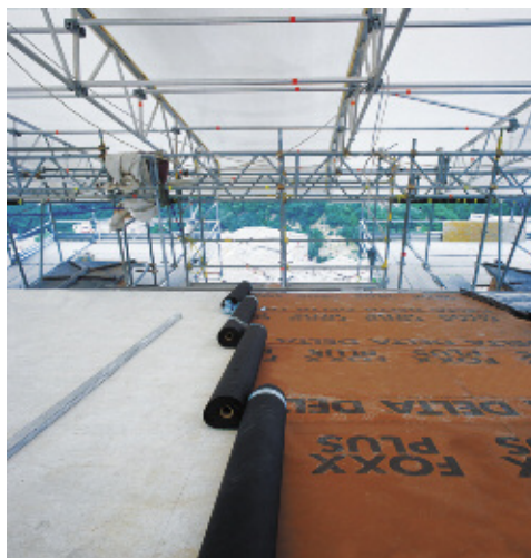
Монтаж гидроизоляционной пленки
