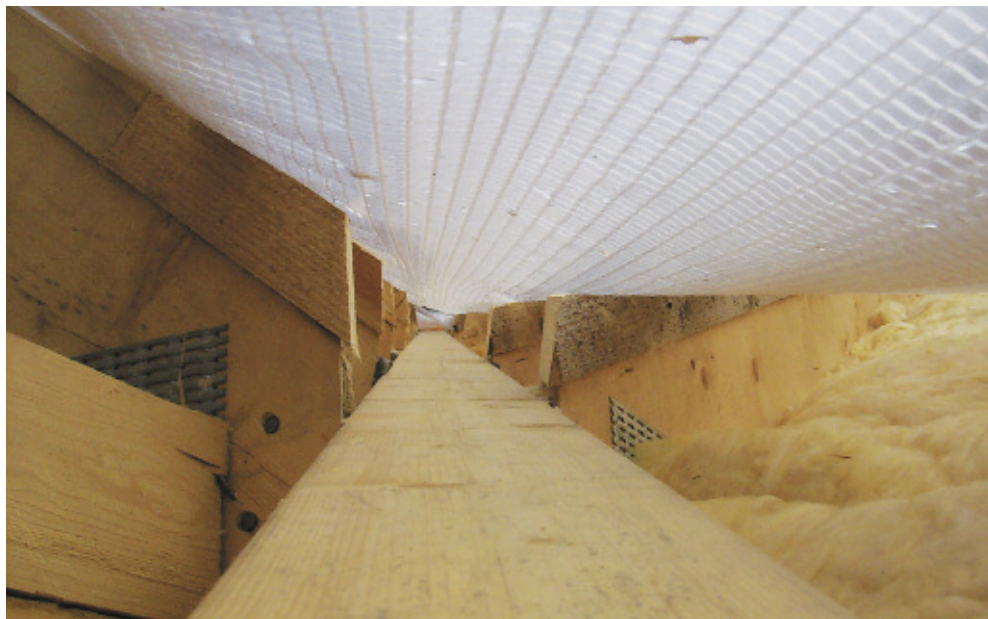
Рис. 3. Организация продольной вентиляции на крыше с микроперфорированной пленкой. Желобок ендовы монтируется на учащенную обрешетку. Достаточный провис пленки обеспечивает сток конденсата (фото автора)
