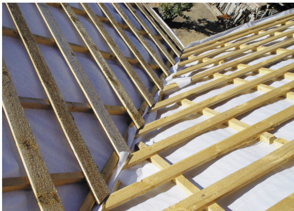
Рис. 4. Ошибка: гидроизоляция уложена с разрывом, контробрешетка прибита гвоздями по линии возможного стока воды, отсутствуют вентиляционные продухи
