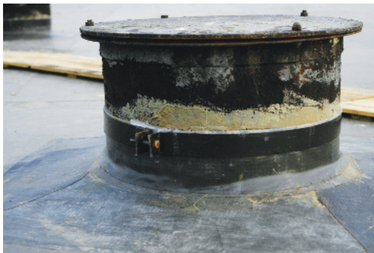
Рис. 6. Устройство выкружки вокруг примыкания к технологическим люкам. Выполнено дополнительное механическое крепление материала. На заднем плане видны деревянные щиты пешеходных настилов
