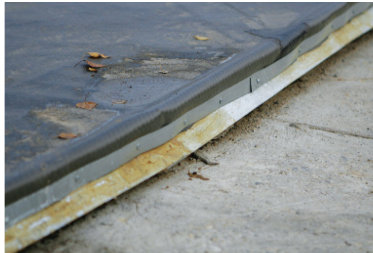
Рис. 7. Дополнительное механическое крепление материалов на металлических свесах кровли
