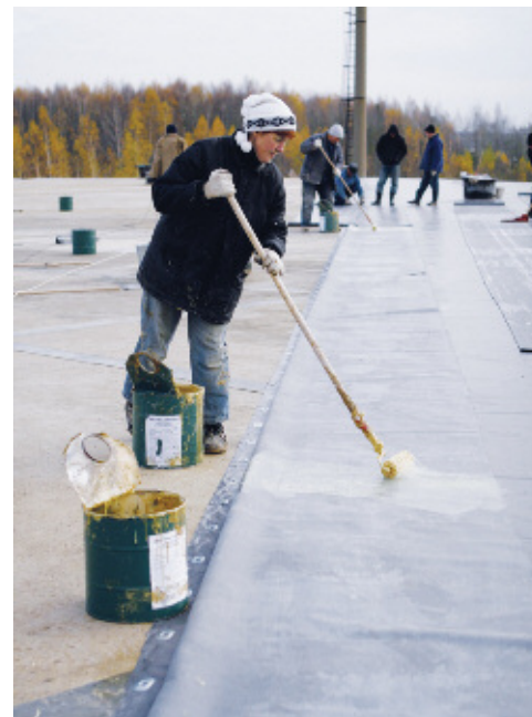
Рис. 5. На сваренное по шву с нижележащим материалом полотнище наносится слой клеящей мастики
