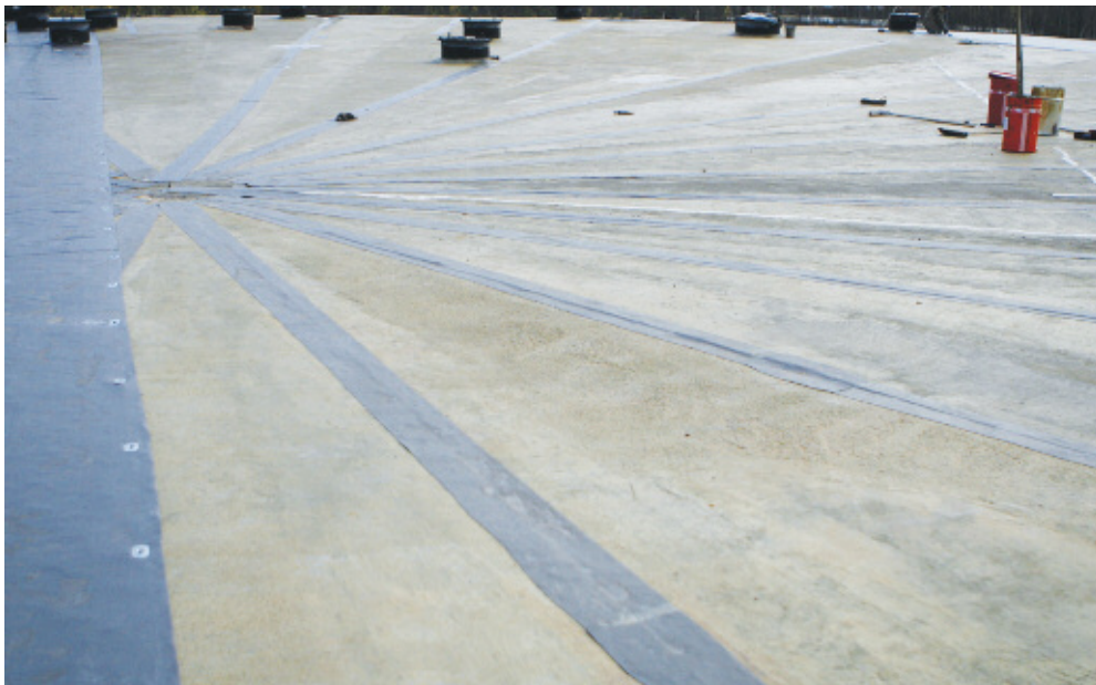
Рис. 1. Огрунтованное бетонное основание кровли хранилища мазута Костромской ГРЭС с предварительно оклеенными деформационными швами.
