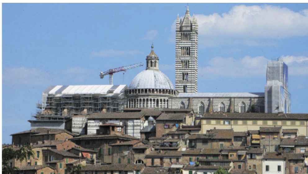
Реконструкция кровли центрального нефа
