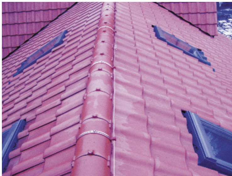
Элементы молниеприемной сетки на кровле
