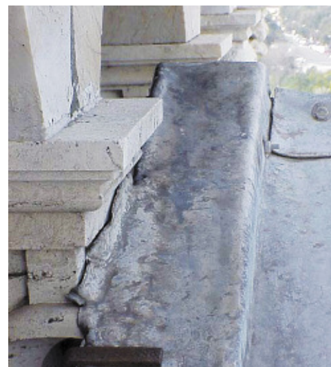
Фрагменты старого свинцового покрытия кровли
