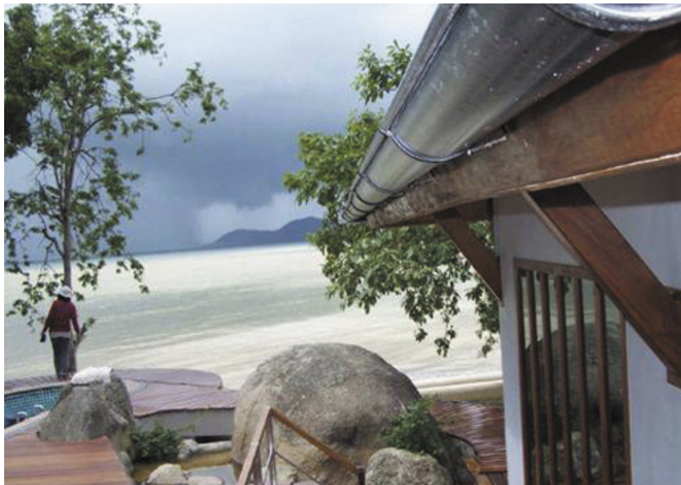
Водосточная система Lindab на фасаде дома семьи Бекхэм на Koh Samui
