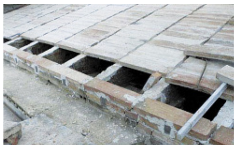
Монтаж основания под стяжку
