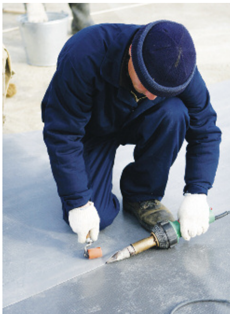
Рис. 4. Сваривание материалов по шву аппаратом горячего воздуха
