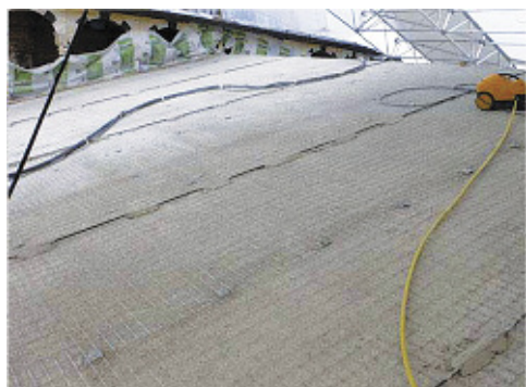
Подготовка основания из выравнивающей стяжки, армированной сеткой из нержавеющей стали
