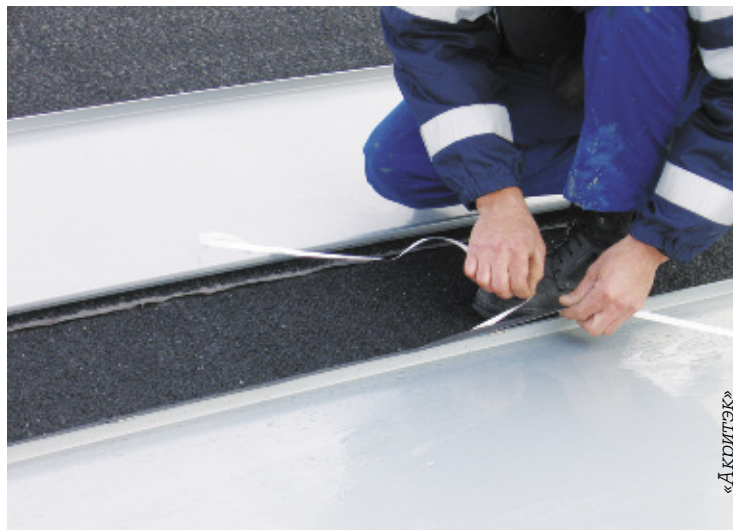
Монтаж кровли Третьего гуманитарного комплекса МГУ: малоуклонная кровля из титан-цинка потребовала применения структурной мембраны
