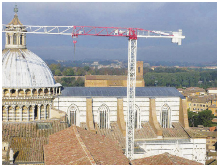
Свинцовая кровля центрального нефа (предел Св. Джованни) после реконструкции
