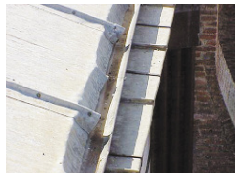
Свесы и примыкания старой свинцовой кровли
