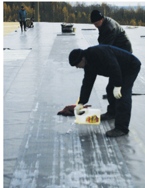
Рис. 2. Подготовка материала «Изолен»: очистка от талька и обезжиривание
