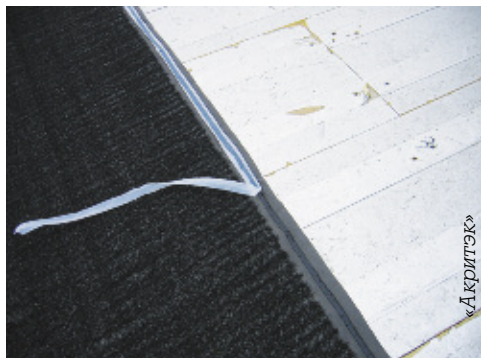
Монтаж структурной разделительной мембраны производится по сплошному основанию
