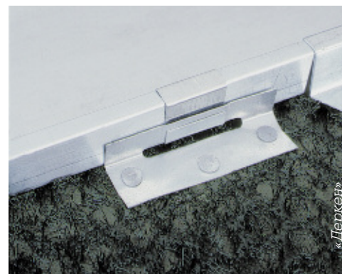
Крепление картин фиксированными и скользящими кляммерами
