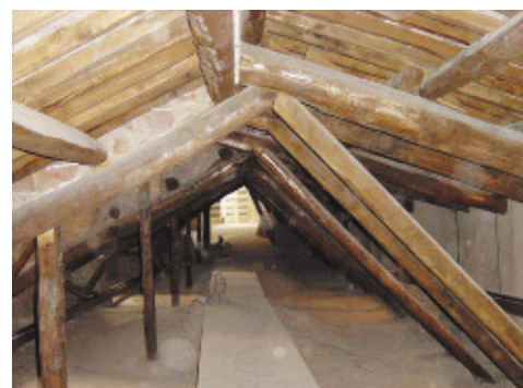
Технические помещения под кровлей центрального нефа
