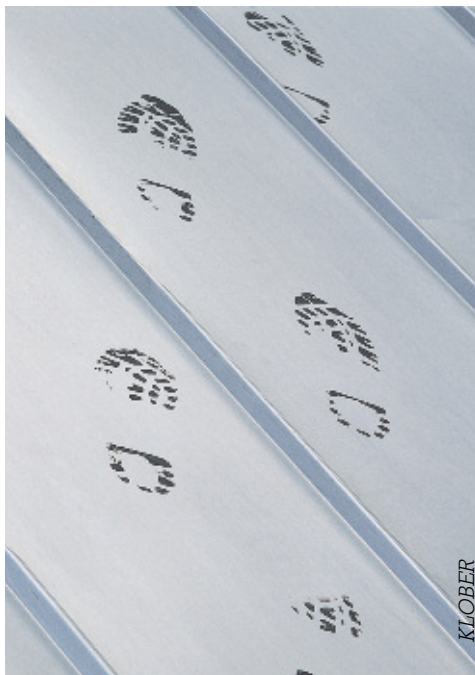
При работе с битумными разделительными прослойками зачастую происходила поверхностная коррозия кровли
