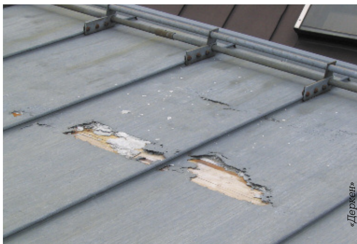
Даже долговечный металл (цинк) может прийти в негодность при отсутствии структурной мембраны в пологих крышах со сплошным основанием
