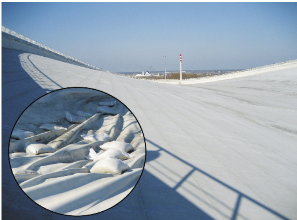
На кровле сложной криволинейной формы мембрану сорвало на одном из участков примыкания к парапету
