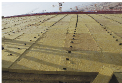
Подготовленная для укладки профилей поверхность крыши: три слоя теплоизоляции
