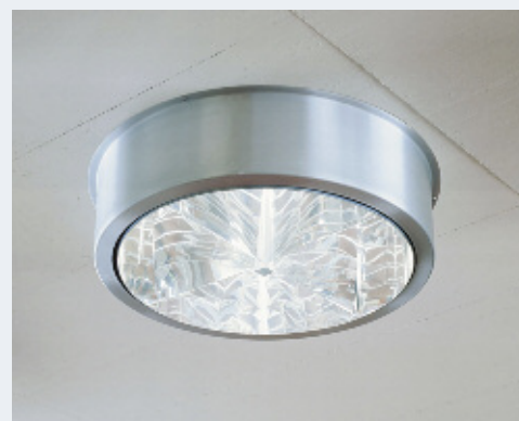
Световод в офисном помещении
