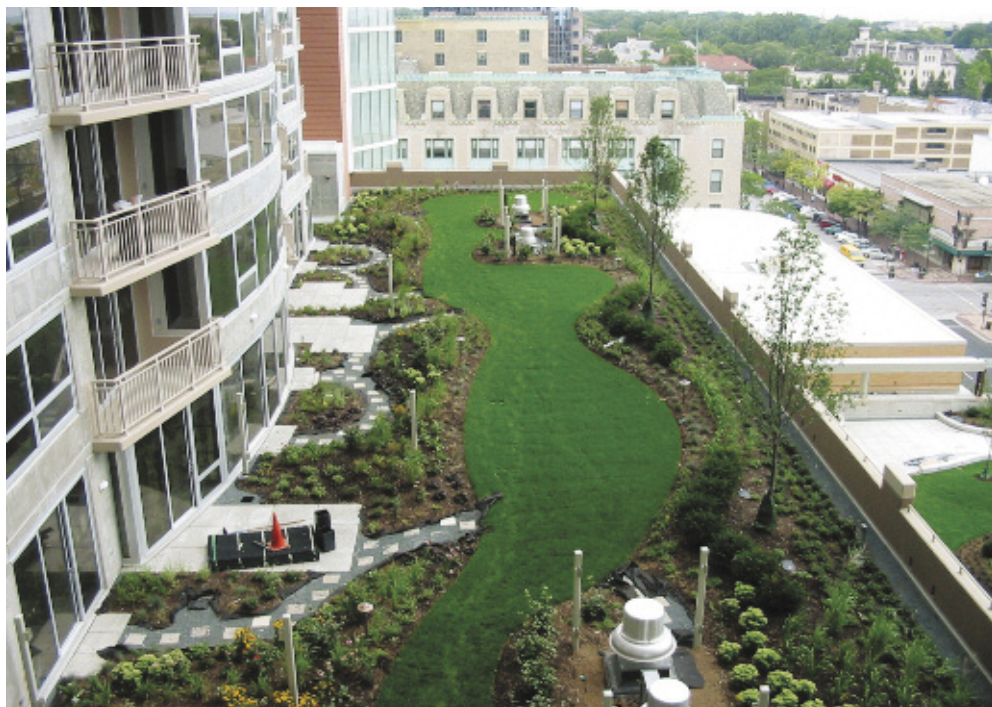
Пример оформления крыши стилобата по системе интенсивного озеленения
