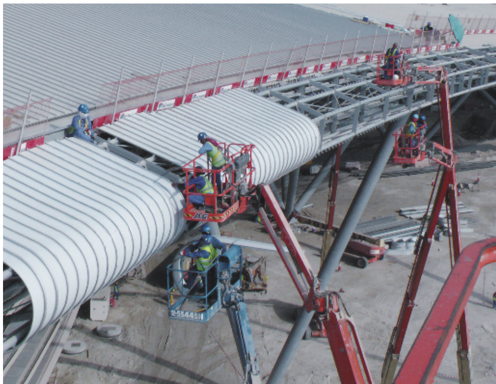
Монтаж профилей кромки кровли
