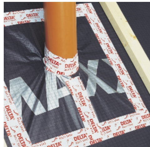
Рис. 8. Уплотнение вентиляционной проходки кровельной манжетой (BRAAS)
