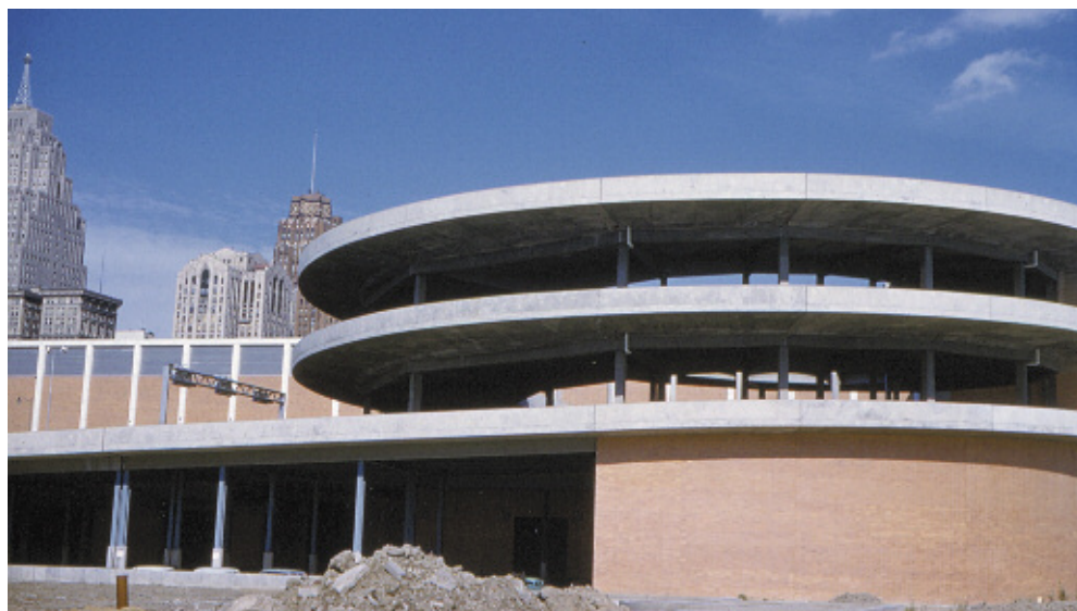
Въезд-пандус на кровельную парковку, Детройт, США
