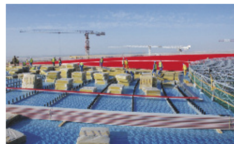
В ходе работ в общей сложности было израсходовано следующее количество материалов: 3 036 рулонов пароизоляции; 114 712 упаковок теплоизоляции; 139 347 омега-профилей; 353 949 термодержателей Interfalz®; 596 рулонов алюминия
