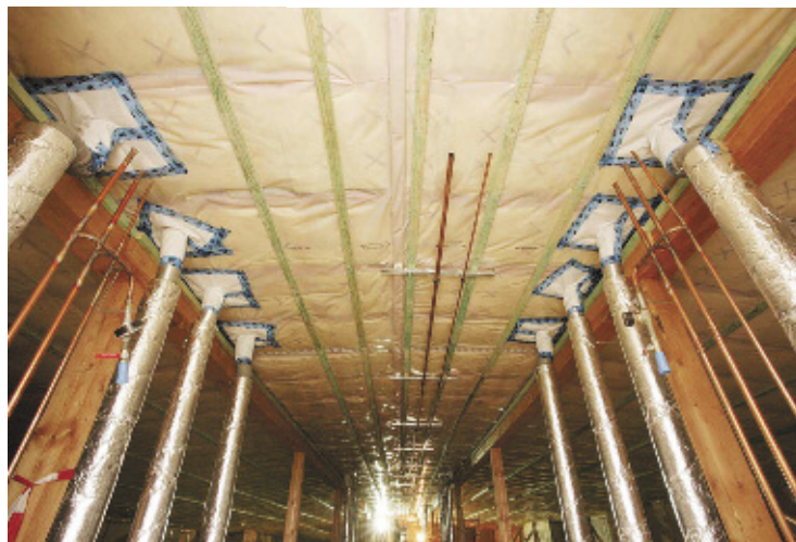
Рис. 9. Варианты уплотнения проходки лентами (DÖRKEN)
