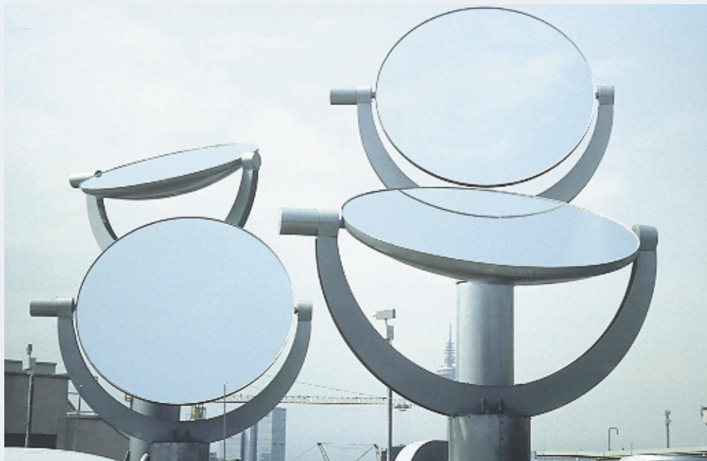
Гелиостат, установленный на крыше здания, позволяет перенаправить солнечный свет внутрь через светопрозрачные проемы
