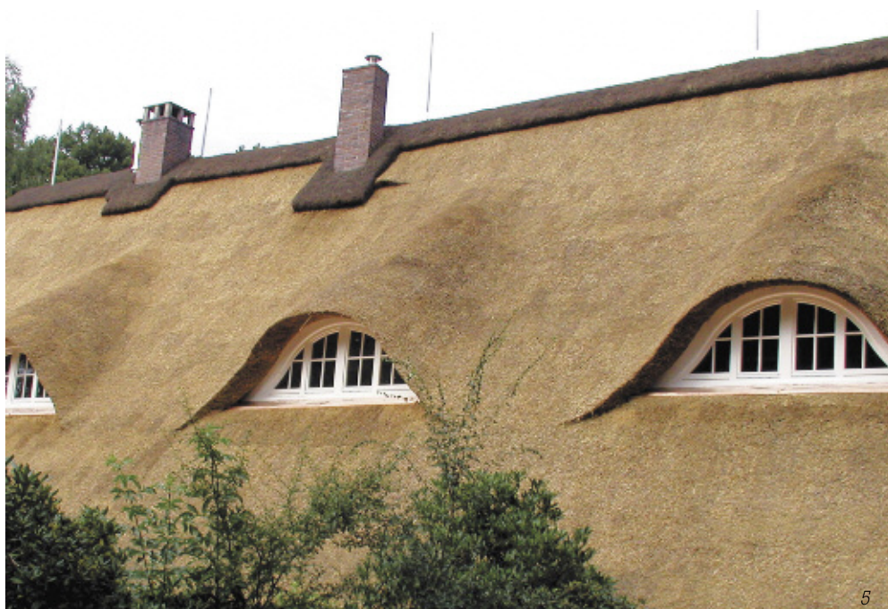
Рис. 5. Тростник, камыш или солома исключительно пожароопасны. Их молниезащита требует особого внимания
