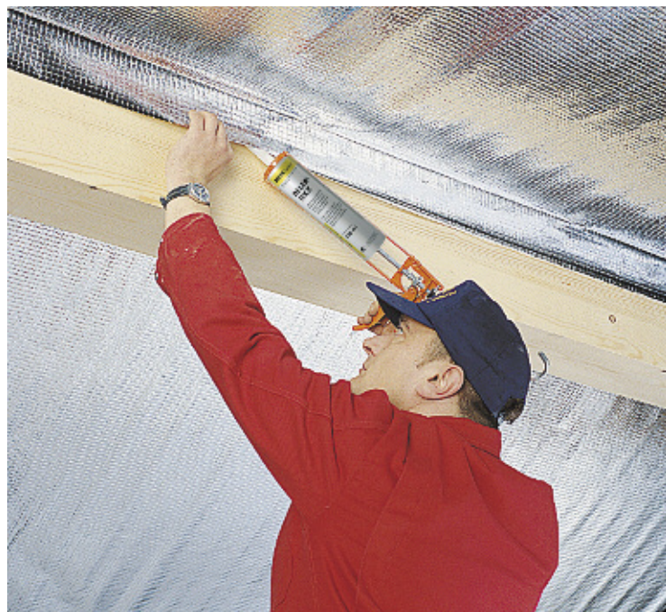
Рис. 3. Монтаж пароизоляции на закрытом прогоне
