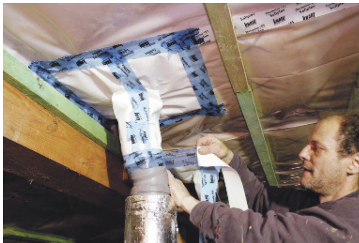
Рис. 7. Уплотнение канализационной трубы односторонней лентой (KNAUF)
