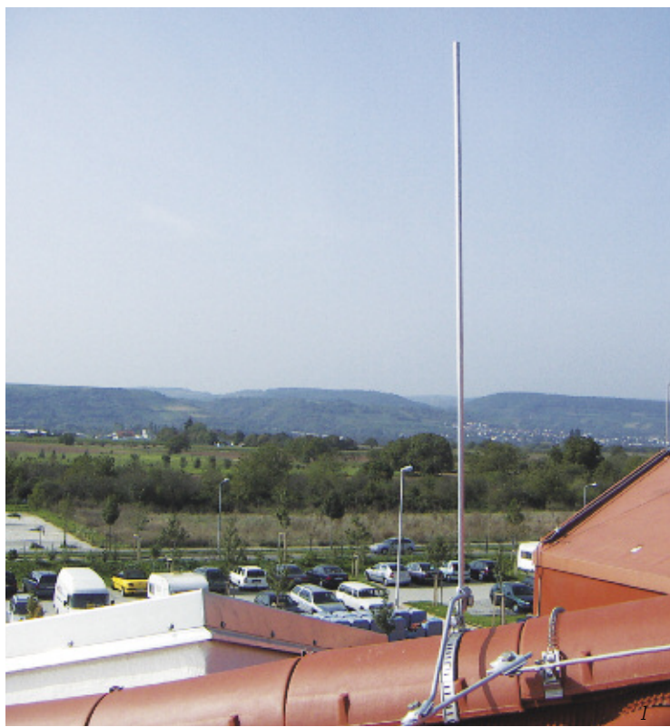
Рис. 1. Зажим с узлом крепления для стержневого молниеотвода (на примере решений DEHN+SÖHNE, Арт. №123 109)
