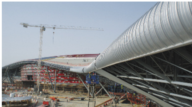
Закрытый фасад, который подчеркивает и делает акцент на линиях и конфигурации кривых архитектурного проектирования
