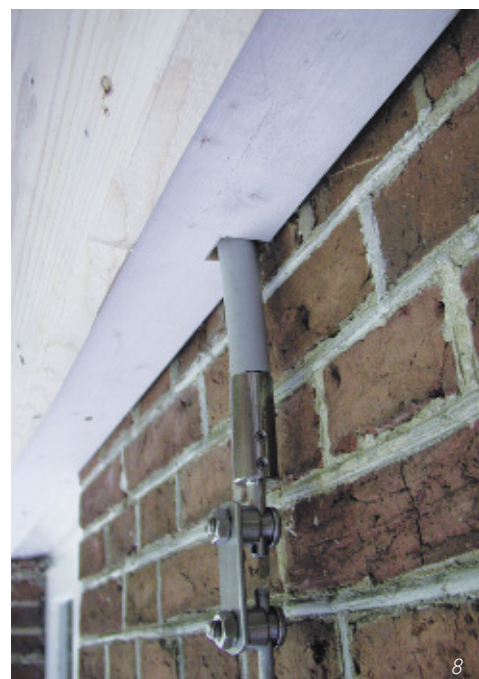
Рис. 8. Подключение к токоотводу – ввод проводника HVI через карнизную доску
