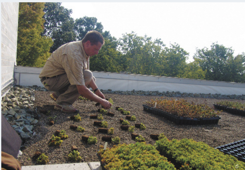
Седумы могут высаживаться как предварительно подготовленными рулонами (а), так и рассадой (б)
