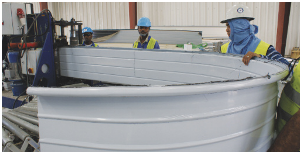
Изготовление профиля для кромки здания
