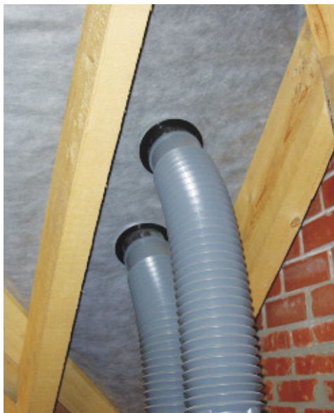
Рис. 8. Уплотнение вентиляционной проходки кровельной манжетой (BRAAS)
