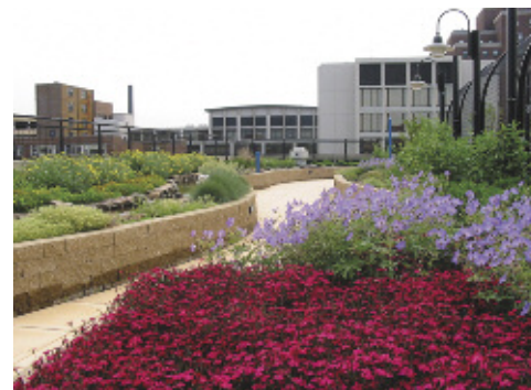
Растительный слой по экстенсивной системе озеленения может быть приподнят относительно основного уровня кровли
