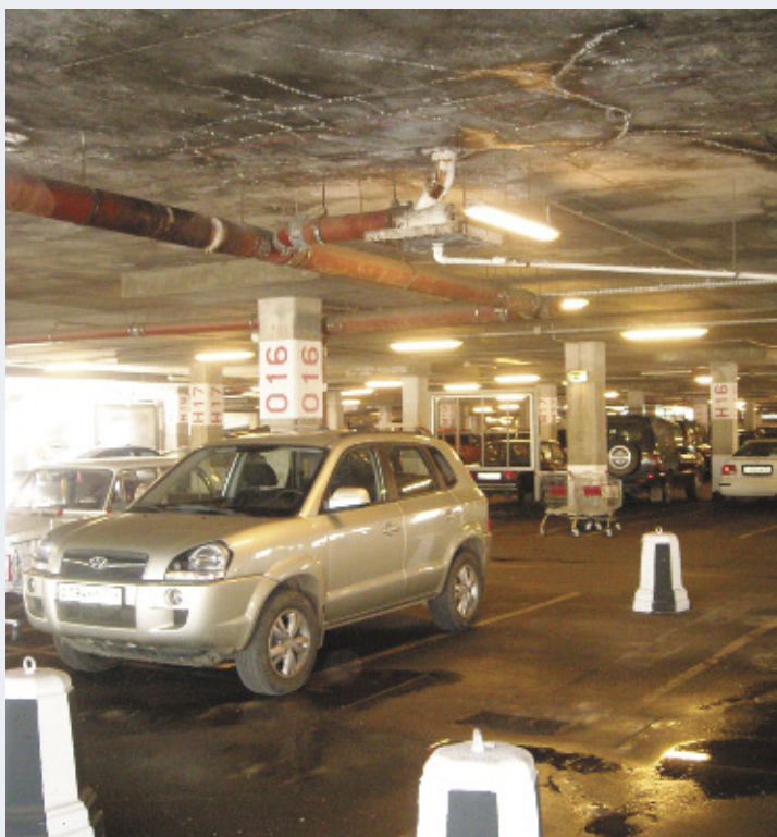
Система водоотвода выполнена из чугуна (красная труба). Обратите внимание на белую дополнительную трубу – это «самодельная» попытка исправить ситуацию, отвести воду. Однако процесс разрушения узла кровельной воронки под воздействием высолов продолжается, и однажды эта тяжелая чугунная труба рухнет на стоящие под ней машины или на людей. Учитывая, что воронок на парковку приходится несколько десятков, то шанс обрушения возрастает многократно.
