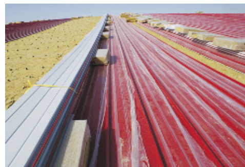
Укладка профилей Interfalz®: длина профиля – 96 м, высота – 50 мм
