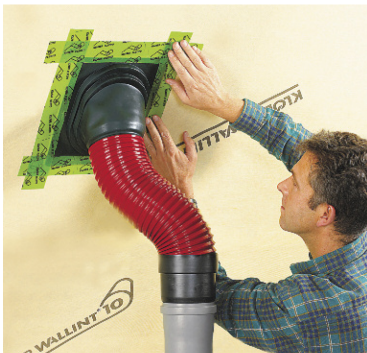
Рис. 5. Уплотнение вентиляционной трубы манжетой или скотчем (KLOBER)
