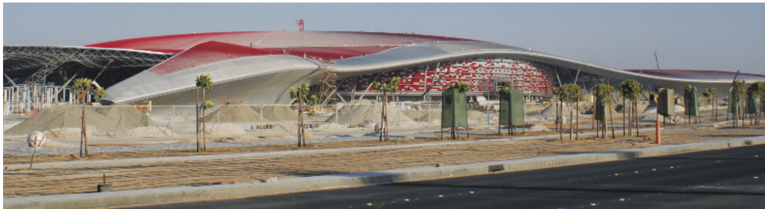
Вид кровли с дороги
