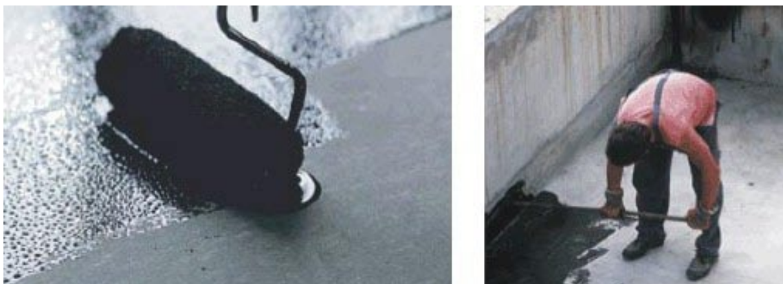
Рис. 5 Нанесение праймера
