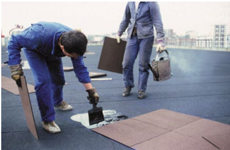
Рис. 12 Укладка плиток Dalle Parcours
