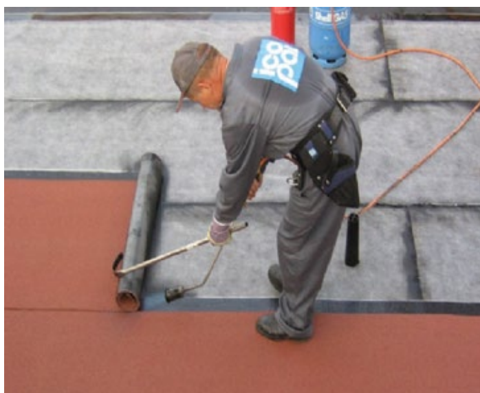
Рис. 13 Укладка верхнего слоя материала наплавлением
