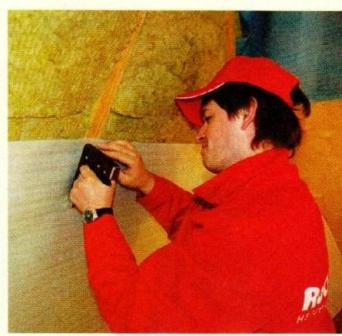
**5** Пароизоляцию крепят с напуском 10 см при помощи строительного степлера. Не следует допускать провисания пленки.
