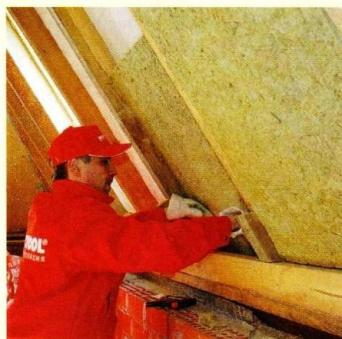
**2** Плиты устанавливают враспор между стропилами. Подрезая плиты, необходимо делать напуск приблизительно 10 см.
