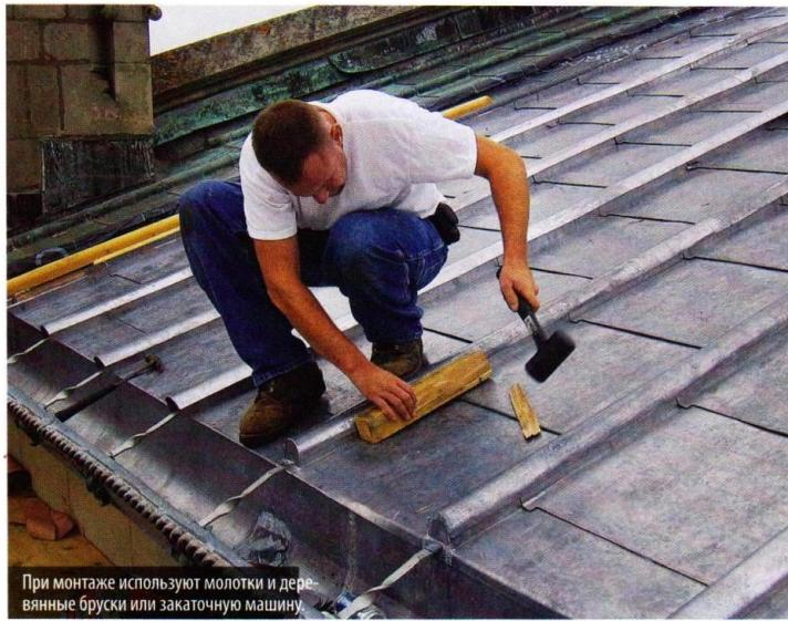
При монтаже используют молотки и деревянные бруски или закаточную машину.
