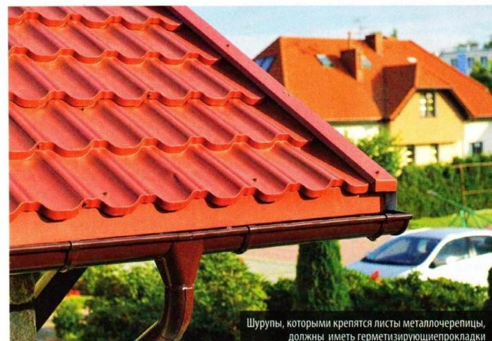
Шурупы, которыми крепятся листы металличерепицы, должны иметь герметизирующую прокладку
