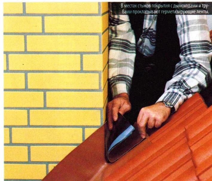
В местах стыков покрытия с дымоходами и трубами прокладывают герметизирующие ленты.
