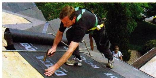
Гидро- и пароизоляция подкровельного пространства. Важная деталь кровли.
