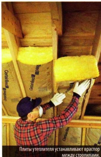
Плиты утеплителя устанавливают внахорку между стропилами.
