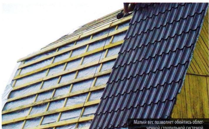
Малый вес позволяет обойтись облегченной стропильной системой.
