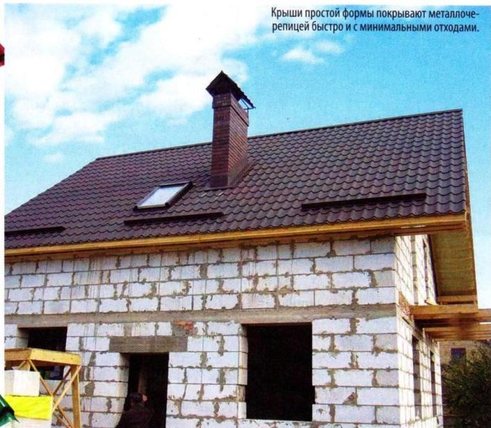
Крыши простой формы покрывают металлочерепицей быстро и с минимальными отходами.
