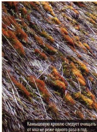
Камышовую кровлю следует очищать от мха не реже одного раза в год.
