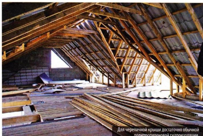
Для черепичной крыши достаточно обычной полипропиленовой гидроизоляции.
