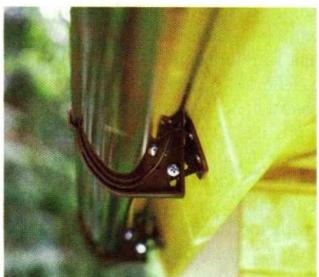
3 Желоб навешивают на кронштейны, чтобы он немного заходил под кровлю.
