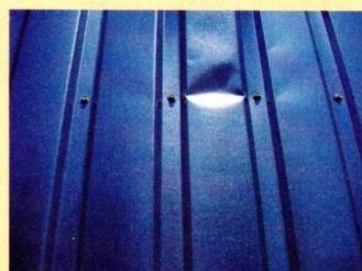
В местах механического повреждения металлическая кровля может начать корродировать.
