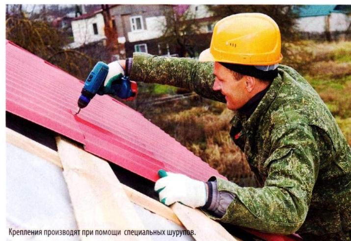
Крепления производят при помощи специальных шурупов.
