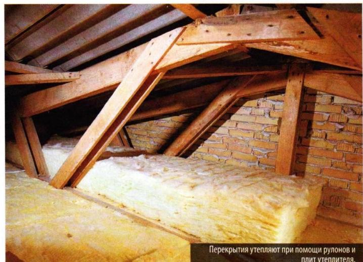
Перекрытия утепляют при помощи рулонов и плит утеплителя.
