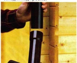
6 На последнем этапе монтируют водосточные трубы.
