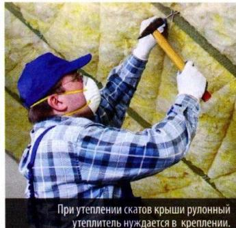
При утеплении скатов крыши рулонный утеплитель нуждается в креплении.
