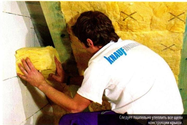
Следует тщательно утеплить все щели конструкции крыши.
